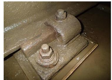
図 1 対象レール締結装置
