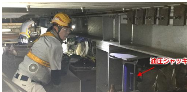
図-7 ホーム低下状況（一般部）
