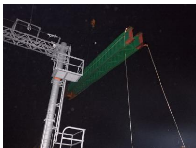
写真-1 架設桁荷揚げ状況①
