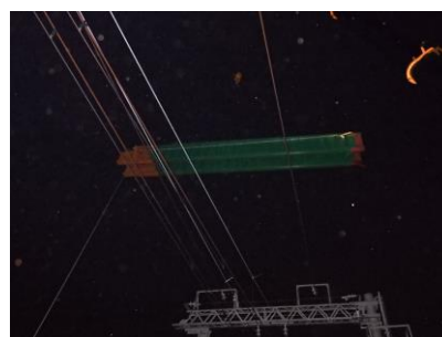
写真-2 架設桁荷揚げ状況②
