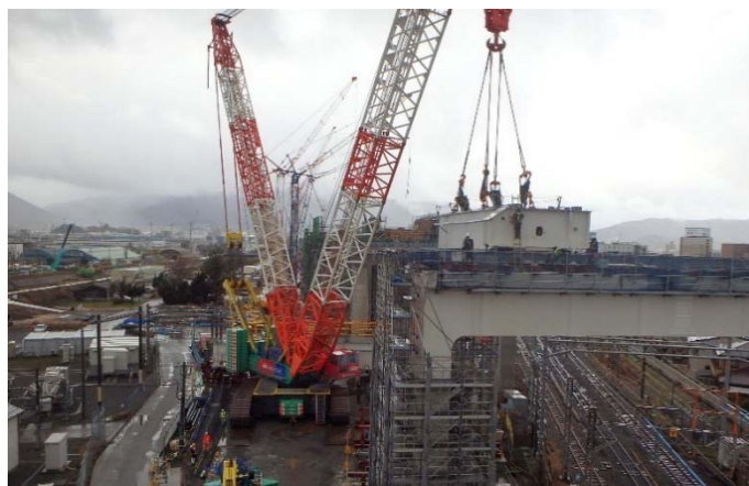
写真-1 架設状況（地組桁①）
