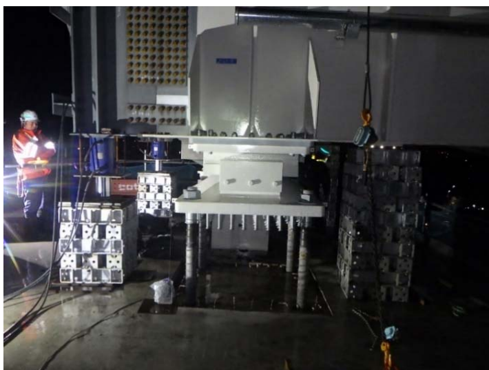
写真-2 桁降下作業状況（P10 橋脚）
