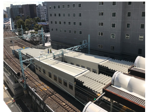
写真－1 現場俯瞰写真
