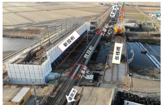
写真-1 現地状況（工事桁架設後）
