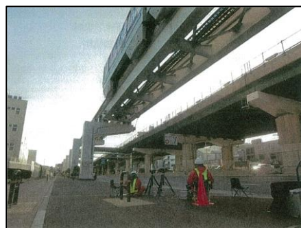
写真-3.1 測定状況
