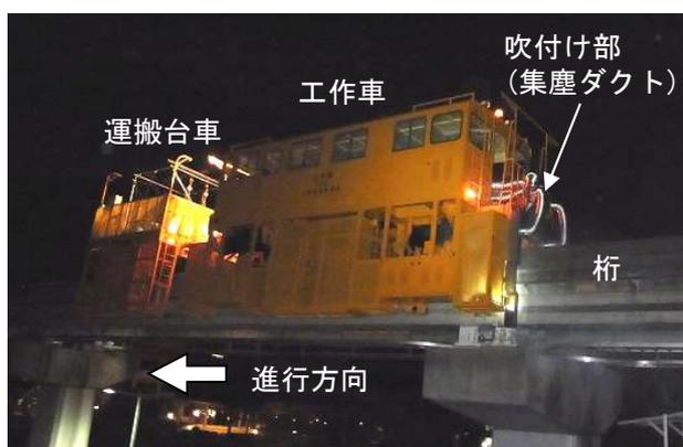
写真-2 吹付け状況(車両編成)
