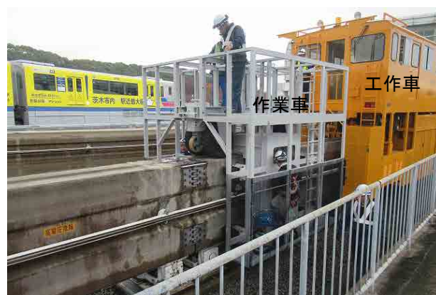
写真－4 桁清掃工状況
