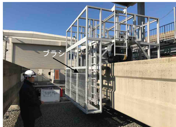
写真－3 素地調整（清掃）専用作業車
