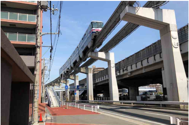
写真-1 軌道桁路下状況
