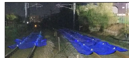
写真-2 レールのシート養生
