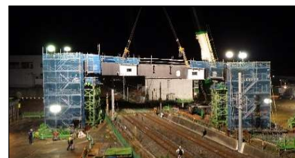
写真-1 横梁架設状況
