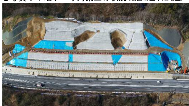
●写真3-2 地すべり対策工の状況(高山市六所地区)
