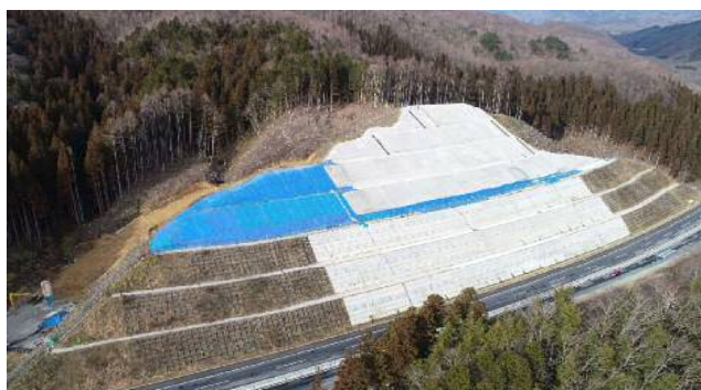
●写真3-1 地すべり対策工の状況(高山市上小鳥地区)
