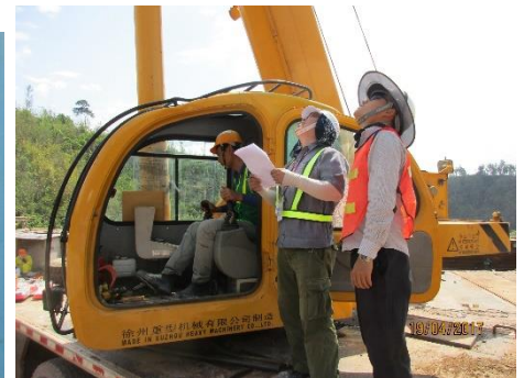
写真-2 技能試験実施状況
