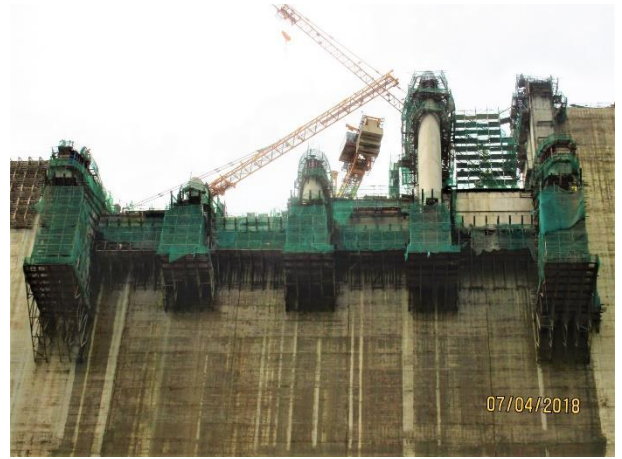
写真-4 作業足場の安全対策
