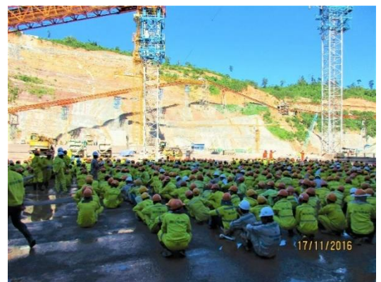
写真-3 安全教育(ダムサイトにて)
