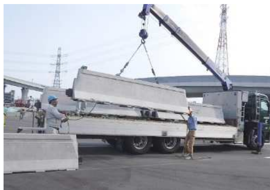
図 6. 据付作業試験
