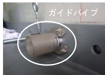
写真-1 ガイドパイプ
