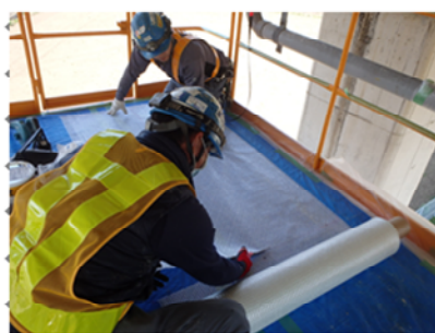
図7 ガラス連続繊維シートの裁断
