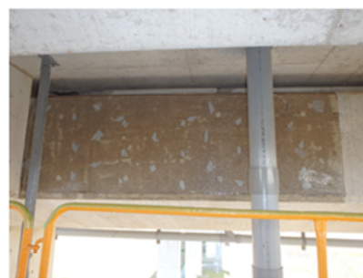
図9 T-One 工法施工完了状況
