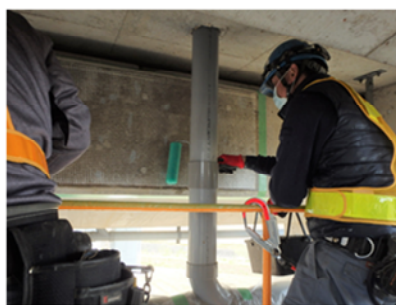
図8 ポリウレタン2層目施工状況
