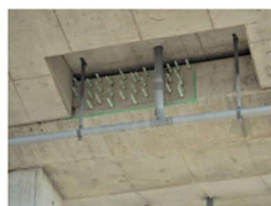
図6 注入材注入状況
