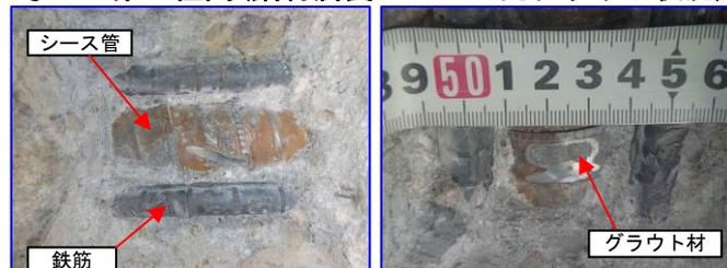
写6 第7径間(鋼材腐食・シース内グラウト状況)
