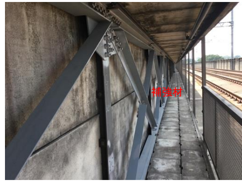
図-5 既設防音壁補強の概況
