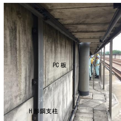
図-3 既設防音壁の概況
