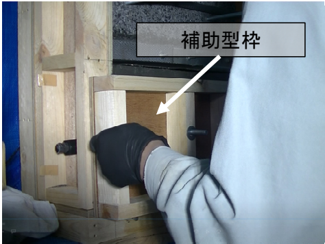
写真-1 補助型枠の概要
