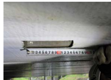
写真 3 浮き内部の確認
