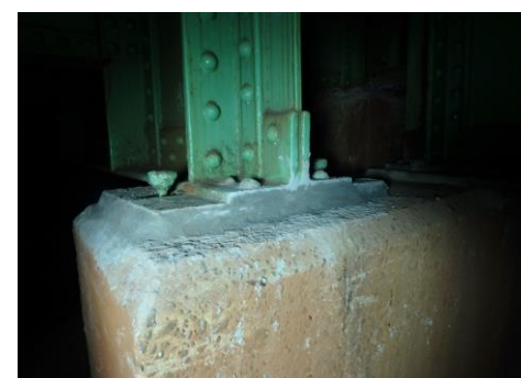
図8 施工後(アクリル樹脂注入後)
