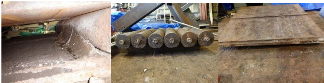
写真-3 ローラー沓内部状況
