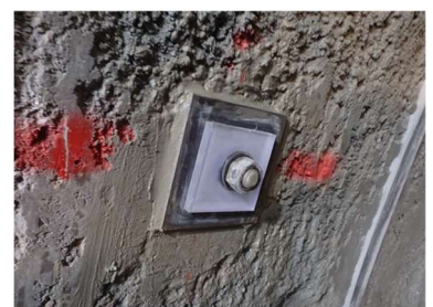
写真-3 試験施工状況
