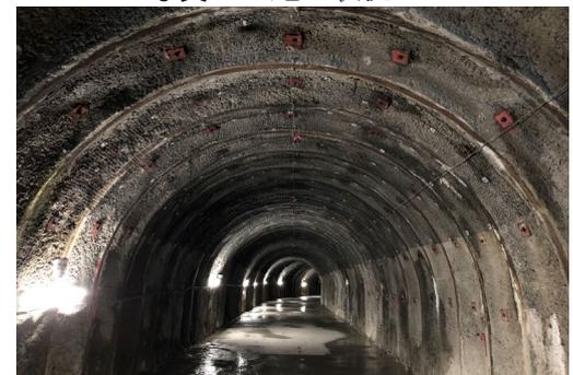
写真-2 高耐力樹脂製ネット設置状況
