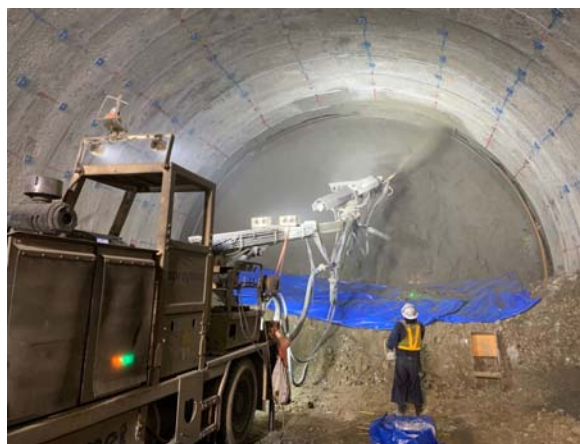
写真-1 リバウンド試験実施状況(天端部)
