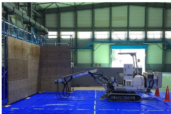
写真-1 吹付実験状況
