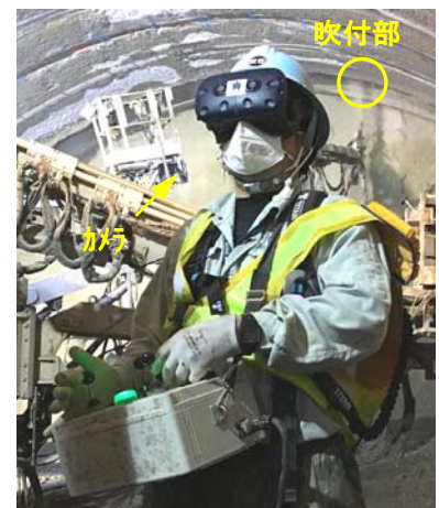
写真-4 HMD遠隔吹付状況
