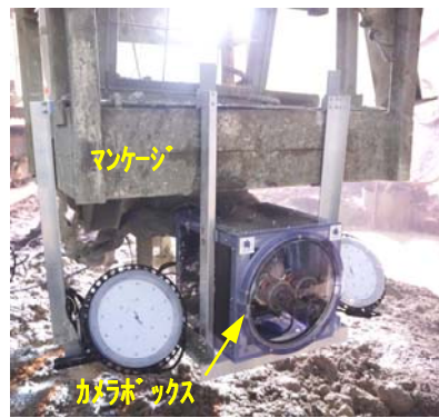
写真-3 カマ設置状況
