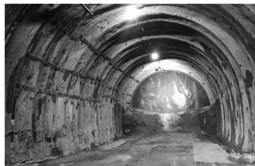
写真-2 追加対策工施工状況
