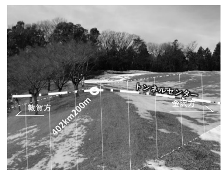
写真-1 盛土部写真
