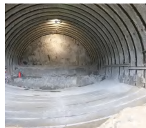
図-8 インバートストラット施工完了
