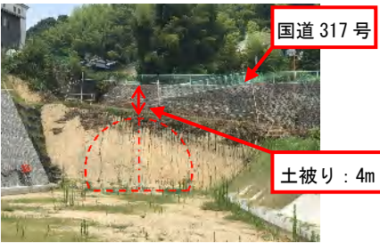
図-1 坑口着工前状況
