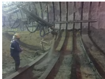
図-7 インバートストラット施工状況
