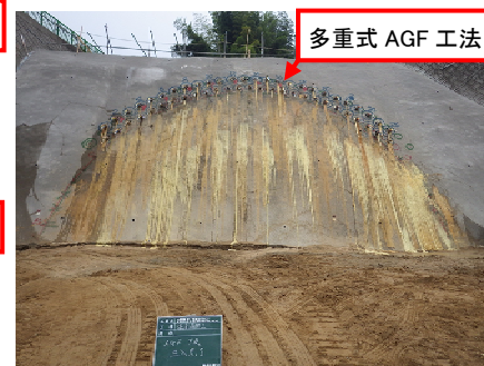
图-5 多重式 AGF 工法施工完了
