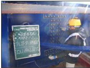
写真-4 ボルト締付確認
