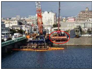
写真-2 作業構台組立
