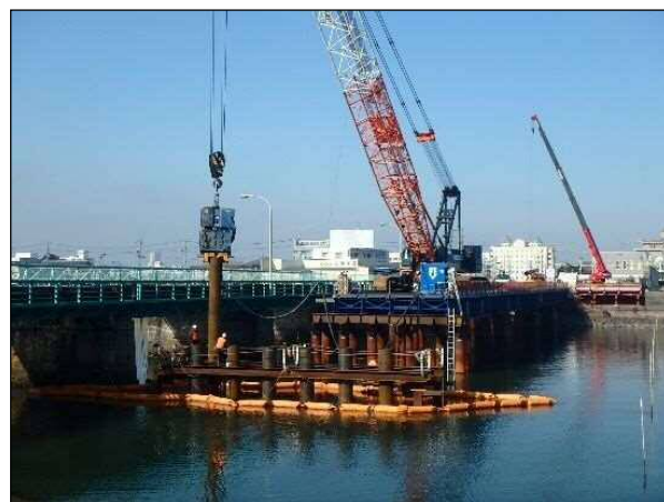
写真-1 鋼管杭打設状況（PVE24VM）
