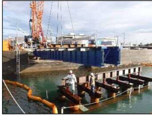
写真-5 上部工組立・架設状況
