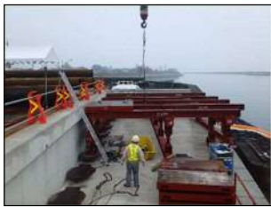
写真-2 作業構台組立
