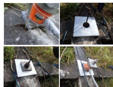
写真2 支圧板の補修状況
