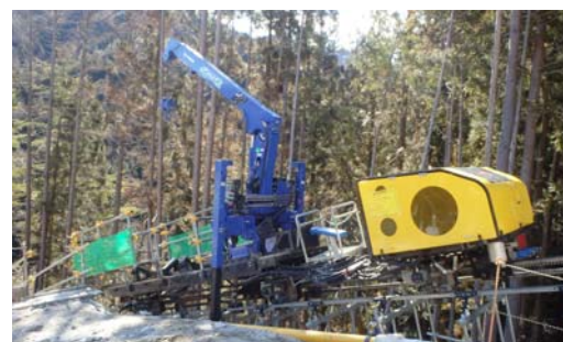
写真-3 クレーン台車
