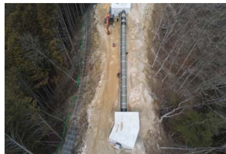
写真-1 水圧管路設置状況 抜粋
