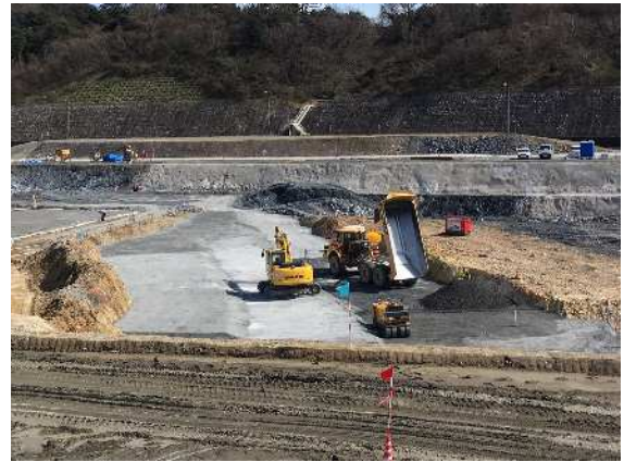
図-5 INSEM 施工状況
