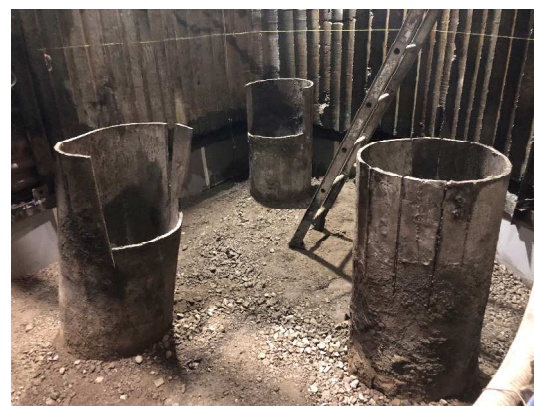
写真-1 支障杭（鋼管杭）
