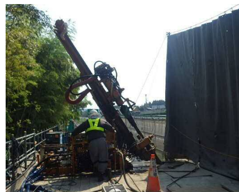
図-3 充填孔削孔状況
