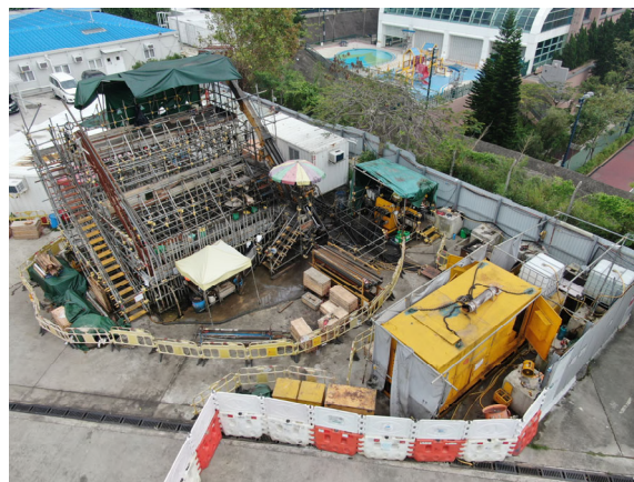
写真－1 ボーリング状況（削孔機は構台右端）
