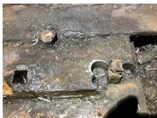
写真-6 ボール盤で床板を穿孔
