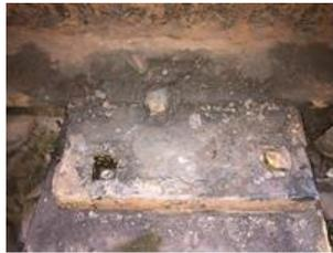
写真-1 車両洗浄機と分岐器 (奥) 写真-2 腐食した床板と犬くぎ
