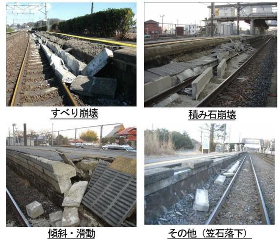
図-1 組積構造の盛土式乗降場の被災例
