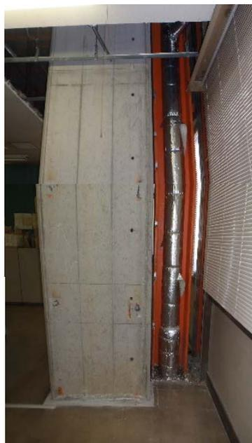
写真-2 補強柱
