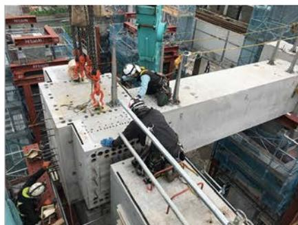
写真4 部材架設状況(接合部)
