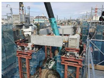
写真3 部材架設状況(接合部)
