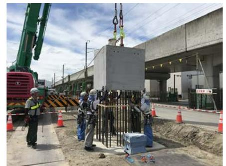
写真 1 柱基部部材据付状況
