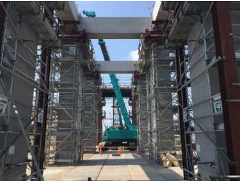
写真 1 試験施工の状況
