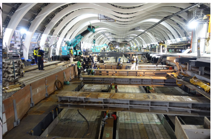
写真-1 施工状況
