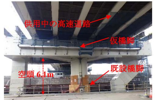
写真-1 撤去する既設橋脚 (P7 橋脚)
