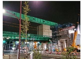
写真-4 架設桁架設状況
