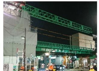
写真-3 手延べ桁架設状況
