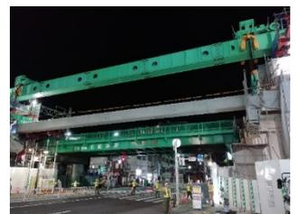
写真-5 PC桁架設状況
