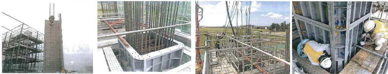
写真-1 吊込み状況(ユニット化) 写真-2 据付け固定状況 写真-3 締固め状況 (内部) 写真-4 締固め状況 (表面)
