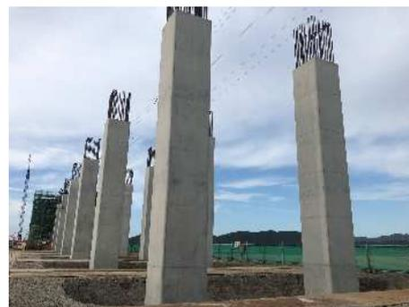
写真-9 支柱用鋼製型枠仕上がり状況
