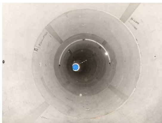
写真－4 坑内完成状況
