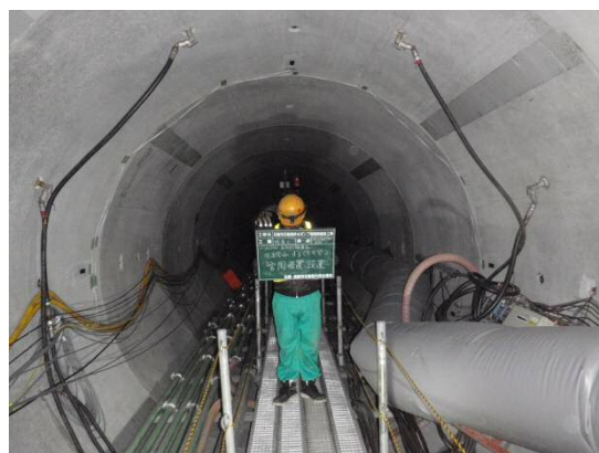
写真-2 多孔管配置状況
