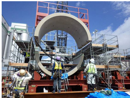
写真-1 推進管組立状況
