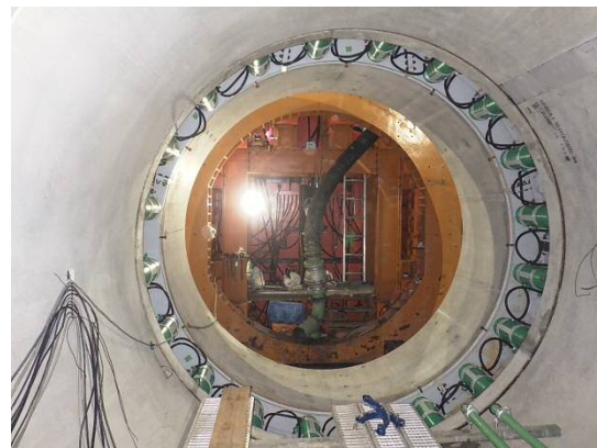
写真－3 中押し管設置状況
