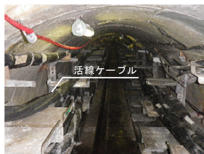
写真-1 洞道内部（着手前）
