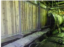
写真-4 側部撤去
