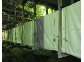
写真-5 撤去完了
