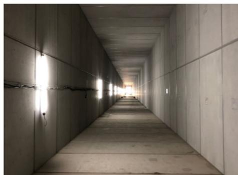
図-8 放水路 フルプレキャスト構築完了状況
