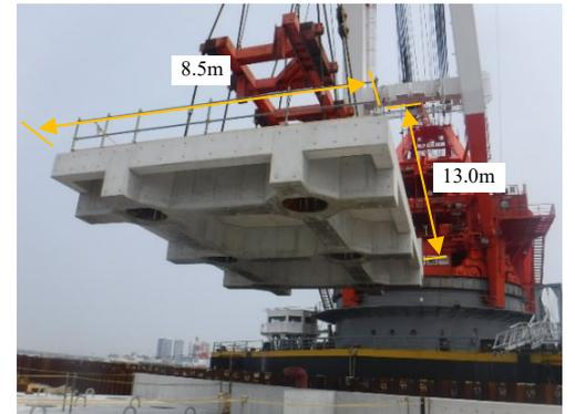
図-6 栈橋上部工 架設状況
