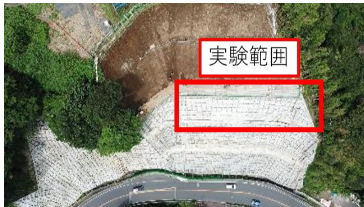
写真-1 現場全景
