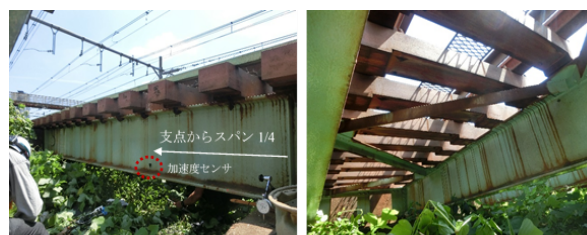
写真-1 現地状況
