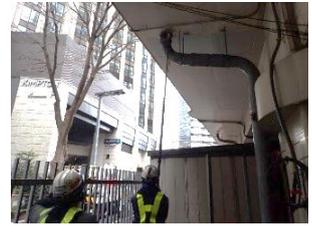
写真-3 作業状況(左：高所作業車を使用した接近点検、右：打検機を使用した打音検査)
